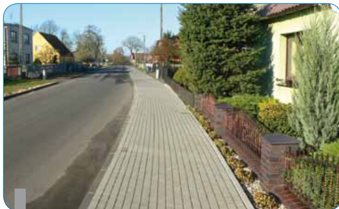
Wyremontowana droga powiatowa i chodnik w Sowinie (gm. Pleszew)
