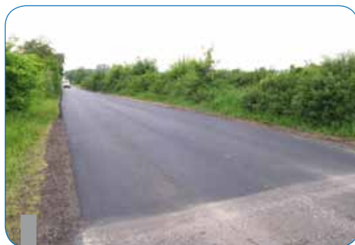
Nowa nakładka asfaltowa w Woli Duchownej (gm. Czermin)
