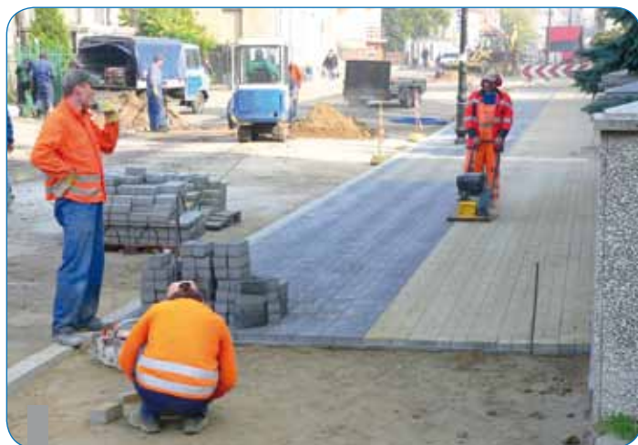
Prace przy budowie nowego chodnika przy ul. Poznańskiej w Pleszewie
