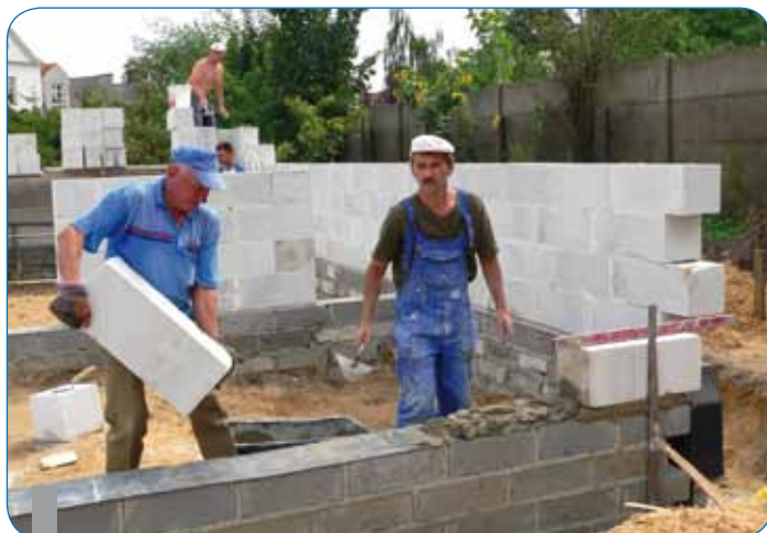
Roboty murarskie przy rozbudowie CKP (2009 r.)
