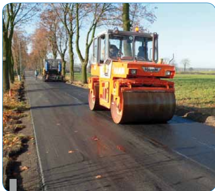
Budowa drogi Bronów - Krzywosądów
