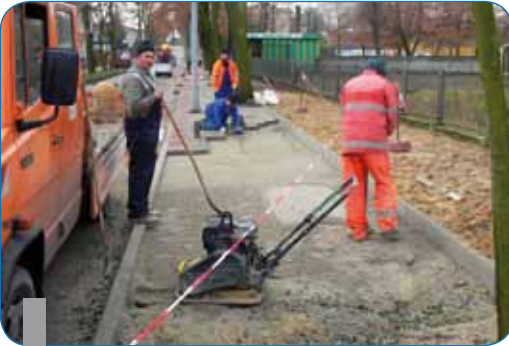
Układanie chodnika przy ul. Podgórznej w Pleszewie
