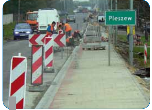
Prace przy modernizacji drogi powiatowej do Dobrzyca na odcinku Pleszew - Kowalew
