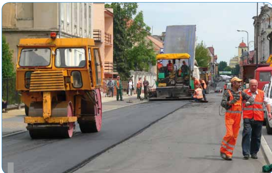
Ulica Poznańska w Pleszewie w trakcie modernizacji
