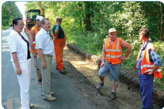
Poszerzanie drogi powiatowej Grab – Czermin (Pieruszyce)
