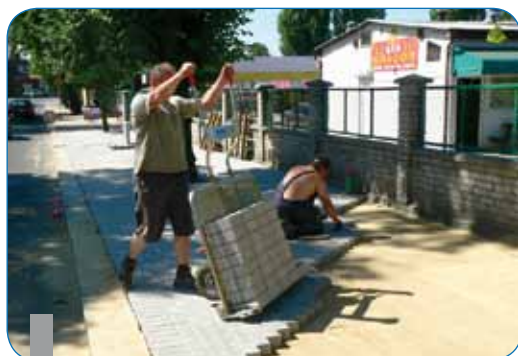
Układanie chodnika przy ul. Ogrodowej w Pleszewie
