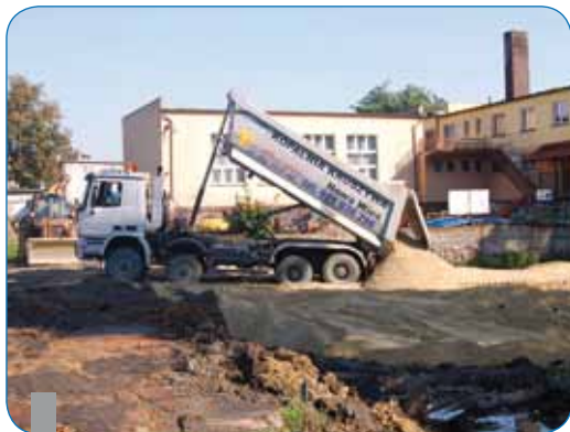
Budowa kompleksu boisk sportowych „Orlik” przy ul. Hallera (2010 r.)
