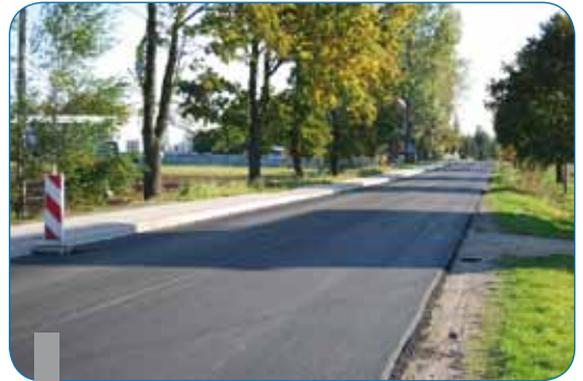
Zmodernizowany odcinek drogi Pleszew – Grab (Czermin)
